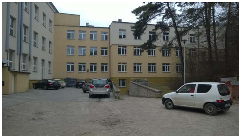
Rys.: Widok na budynek "E" wraz z łącznikiem, placem manewrowym przy łączniku oraz utwardzonym dojściem łączącym plac manewrowy z wyjściem z budynku.
