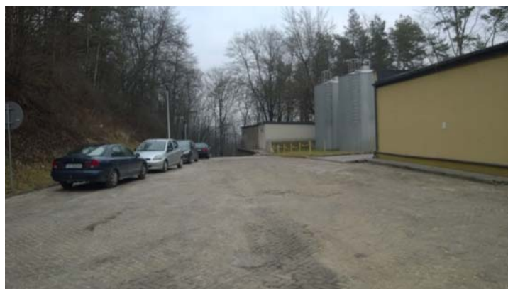
Rys.: Widok drogi dojazdowej do placu manewrowego
